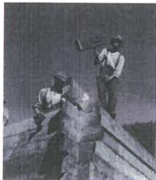
Tecnica di costruzione block-bau (DA PRATI 2018, p. 26)
